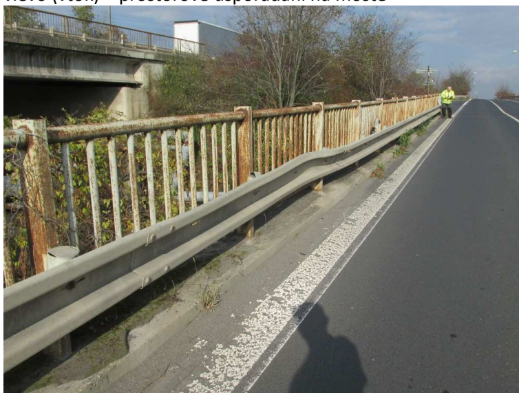
52) Zábradlí a svodidlo vlevo (vtok) – prostorové uspořádání na mostě
