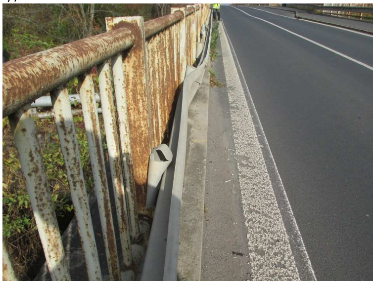
53) Svodidlo vlevo (vtok) / deformace nad OP1
