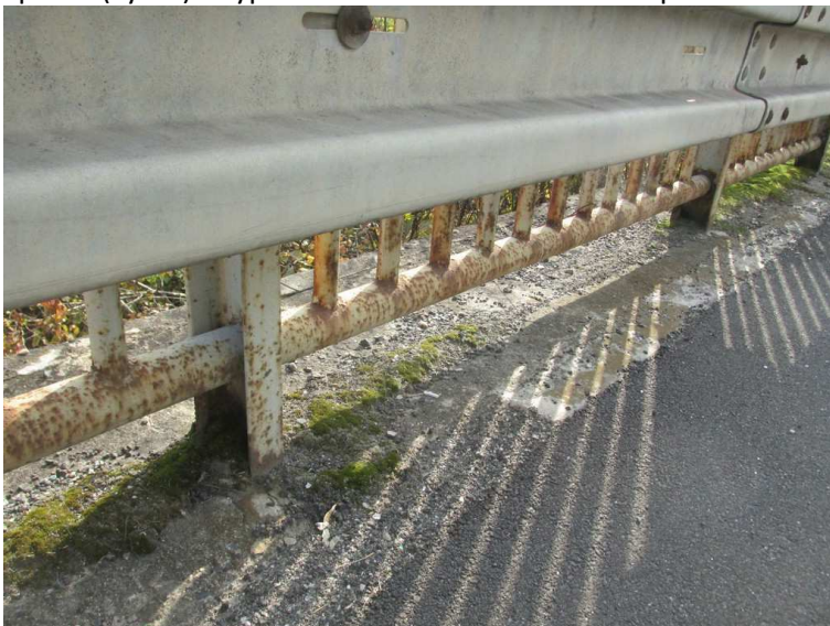
58) Zábradlí a svodidlo vpravo (výtok) – typické kotvení zábradelních sloupků
