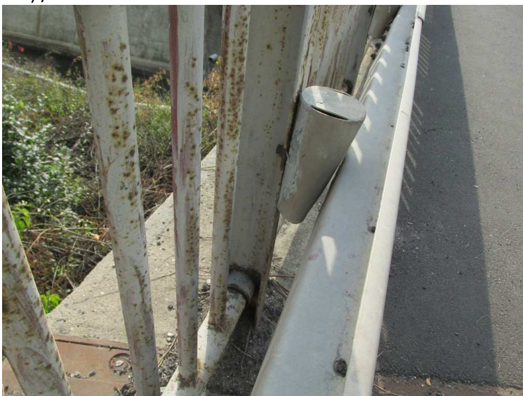
59) Svodidlo vpravo (výtok) / deformace mezikusu nad OP2
